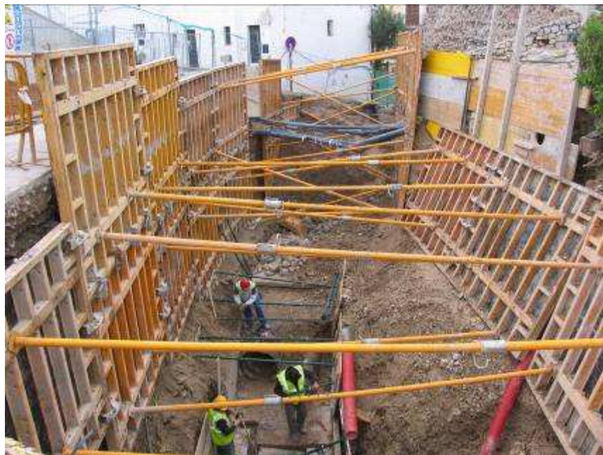
Figura 12. Obres de millora de les infraestructures hidràuliques de Dalt Vila
