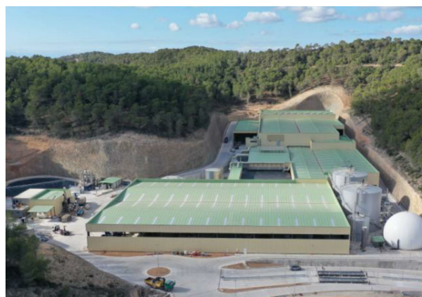
Vista general de la Planta hacia el oeste.
