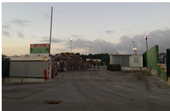
Entrada a las instalaciones.
