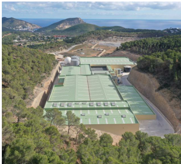
Vista general de la Planta hacia el este.
