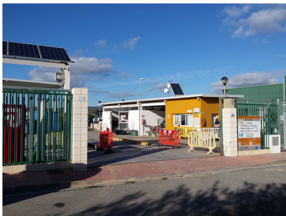
Punto limpio de Ses Païsses.
