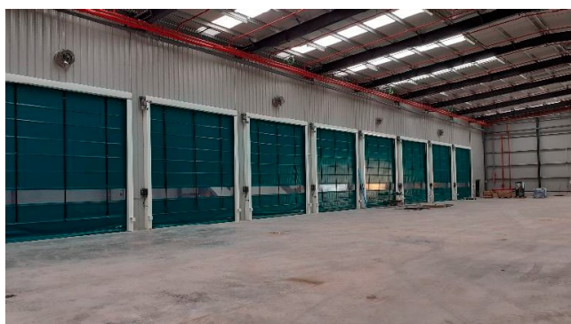
Puertas en los fosos de recepción.
