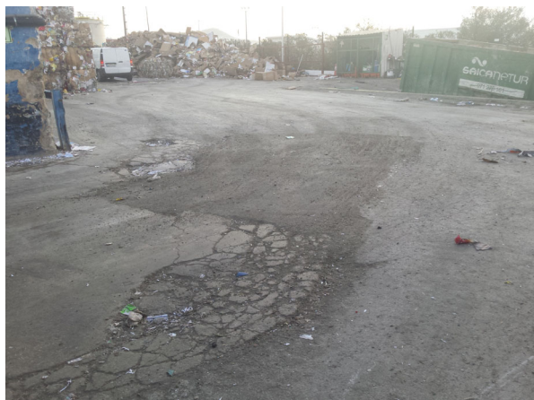
Pavimento de la estación de transferencia.
