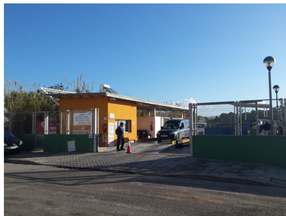
Punto limpio de Montecristo.
