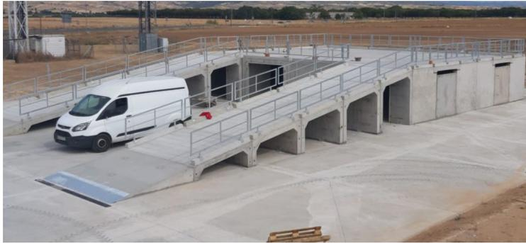
*Ilustración 22. Instalación de un punto de vertido prefabricado con rampas para el vertido*
