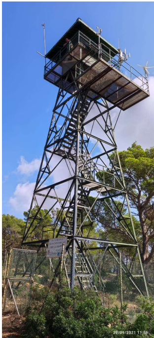
Torre del IBANAT
