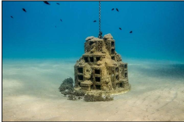
**Figura 7.** Anclaje ecológico tipo Biotopo artificial.
