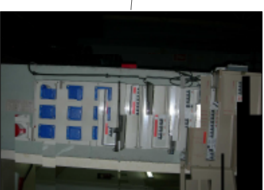
CUADRO ESCENARIO ACOMETIDA 230/400 50A 6 TOMAS II/16 A 1 TOMAS II/25 A 1 TOMAS III/16 A 1 TOMAS III/25 A
