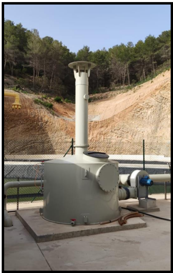
Torre desgasificación depuradora
